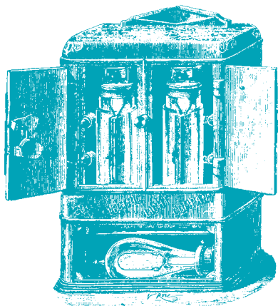
První elektroměr zavedený Edisonem
