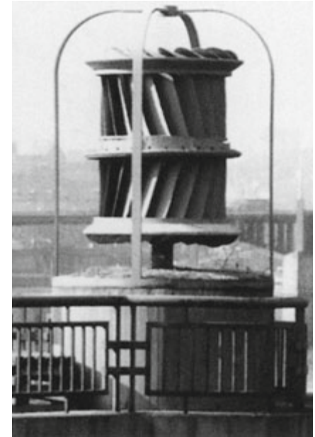
Původní Francisova turbína vodní elektrárny Štvanice
