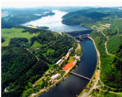
Vodní elektrárna Orlik
