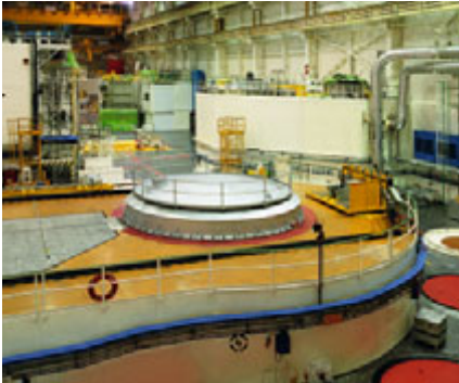
Reaktorový sál Jaderné elektrárny Dukovany
