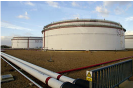
Do 14 zásobníků ropy společnosti MERO v Nelahozevsi se vejde zásoba v objemu více než jednoho milionu metrů krychlových ropy
