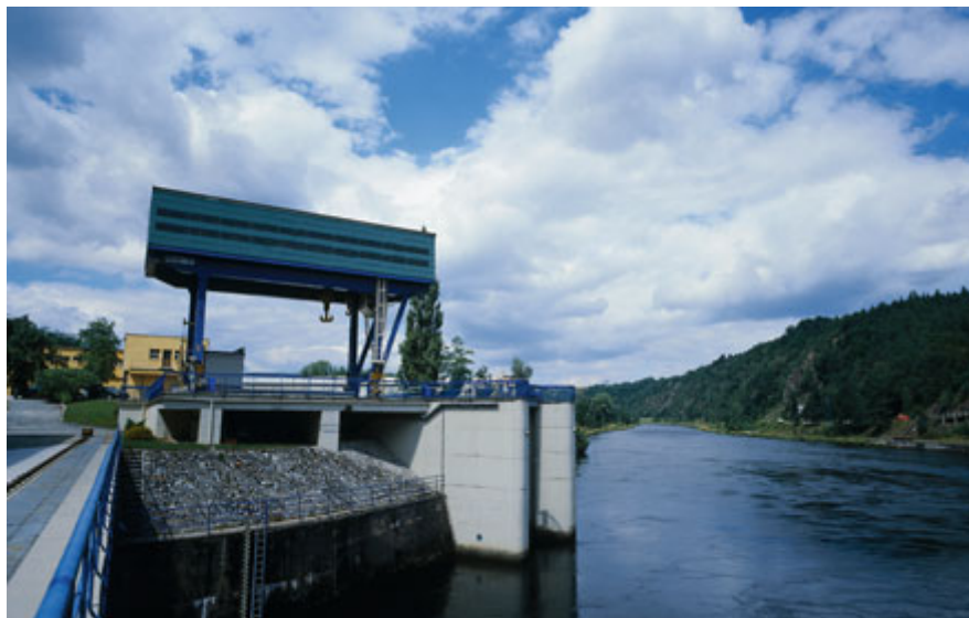
Výpust přečerpávací vodní elektrárny Štěchovice do řeky Vltavy
