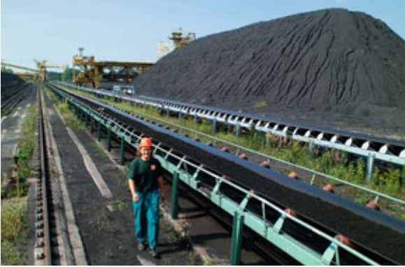
Skládka uhlí v Elektrárně Dětmarovice
