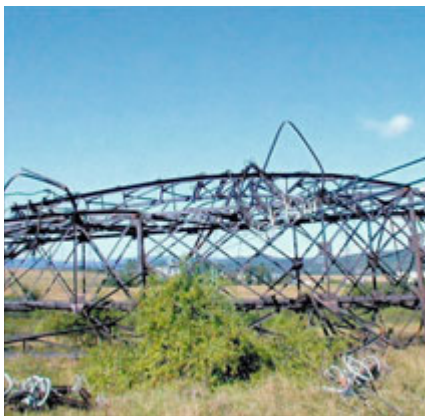
Co dokáže udělat víchřice se stožáry vysokého napětí
