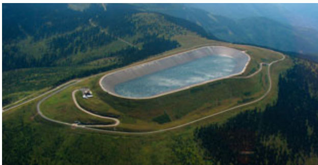
Horní nádrž přečerpávací vodní elektrárny Dlouhé Stráně s obsahem 2,7 milionů metrů krychlových vody leží v nadmořské výšce 1350 m
