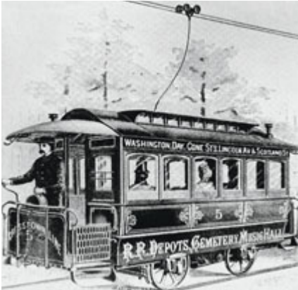
Leo Daft do motoru své první tramvaje v New Jersey přiváděl proud vodičkem, pojezdícím po dvou drátech trolejového vedení
