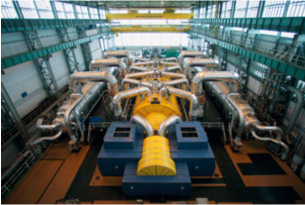
Alternátor ani turbína, která jej pohání, energii nevyrobí, nýbrž pouze přeměňují tepelnou a tlakovou energii páry v mechanickou energii otáčejícího se rotoru, která se indukci v cívkách statoru mění v elektrický proud
