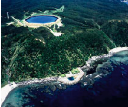
První japonská přečerpávací elektrárna na slané vodu na ostrově Okinawa
