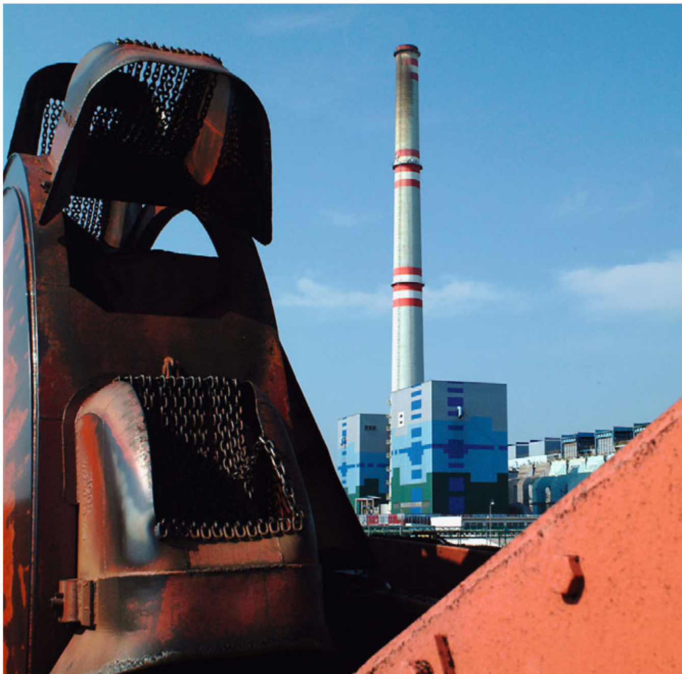
Uhelná elektrárna Prunéřov – rypadlo na skládce paliva
