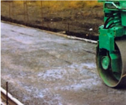
Hutnění vrstvy stabilizátu
