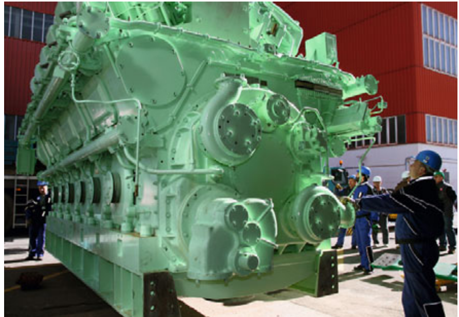
Usazování dieselagregátu, záložního zdroje energie v Jaderné elektrárně Temelín
