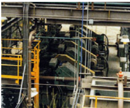
Vysokotlaké čerpadlo k čerpání husté suspenze
