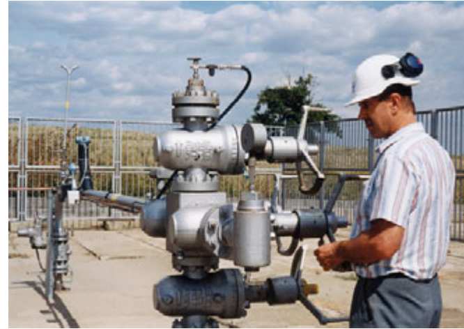
Rozvod plynu – Dolní Dunajovice (Zdroj: RWE Transgas, a. s.)
