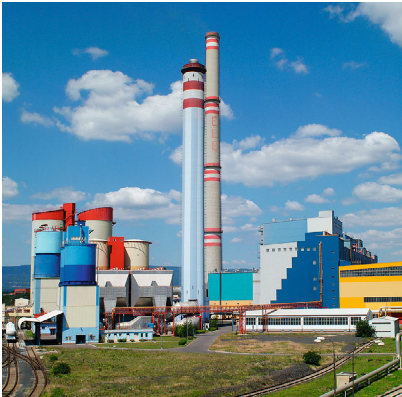
Elektrárna Ledvice před zahájením stavby nového nadkritického bloku
