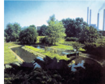
Biologická čistírna vody v Elektrárně Mělník
