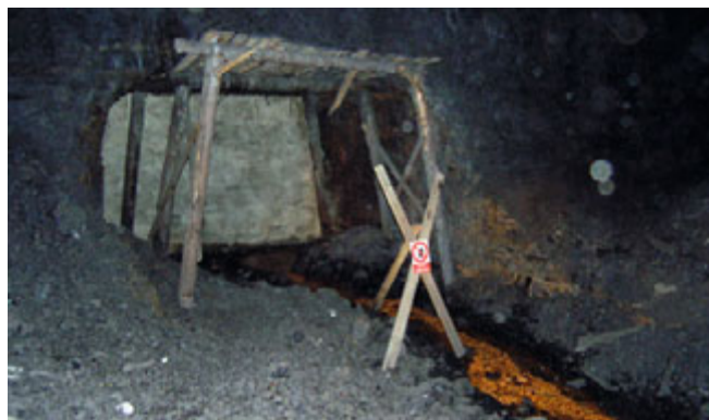
V okolí Biliny se dříve těžilo i hlubinně. Při skryvkách v dnešním povrchovém dole se občas objeví i výdřevy starých chodeb.
