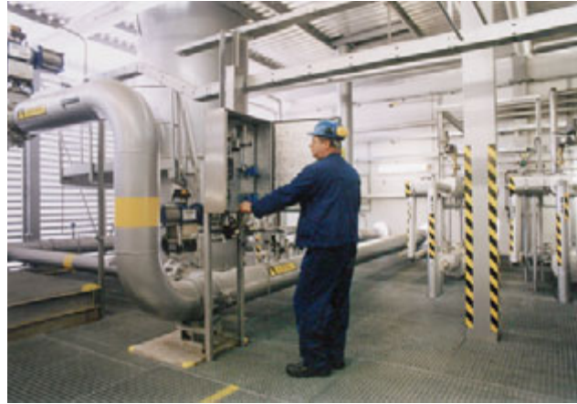
Rozvod plynu – Třanovice (Zdroj: RWE Transgas, a. s.)
