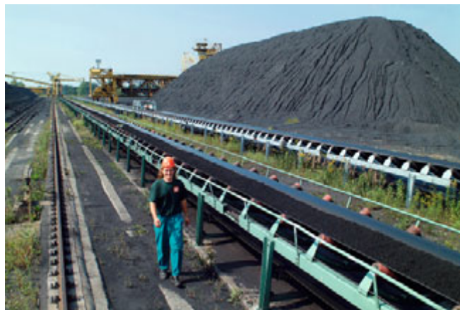
Skládka paliva v Elektrárně Dětmarovice
