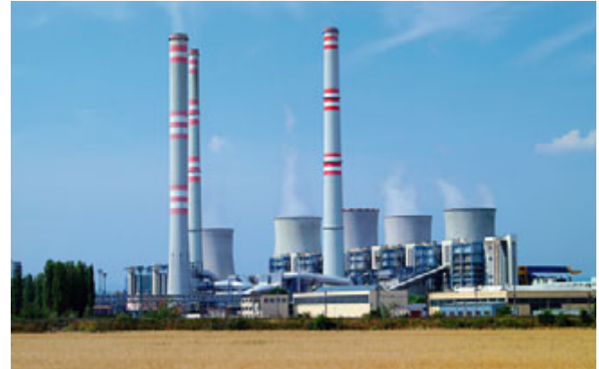
Odsířená Elektrárna Počerady
