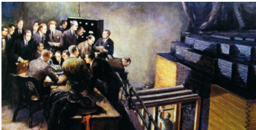
Regulační tyč, balón zavěšený pod stropem v roli ochranné obálky, termometr s radiolampami a detektor neutronů na kresbě znázorňující spuštění prvního atomového reaktoru světa ve sklepení Stagg Fieldu 2. 12. 1942 nejnázorněji ilustrují primitivní zárodky „jaderné bezpečnosti“
