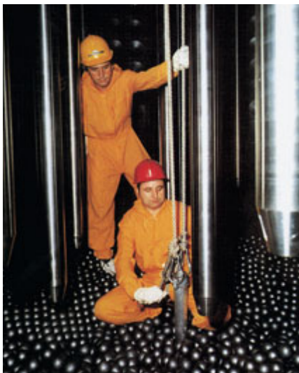
Pohled do reaktoru demonstrační elektrárny HTR-300
