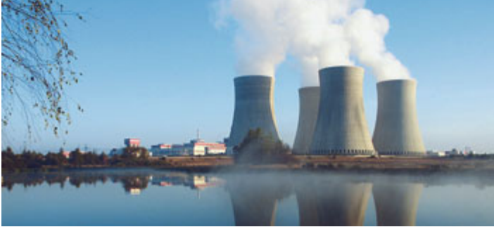
Jaderná elektrárna Temelin
