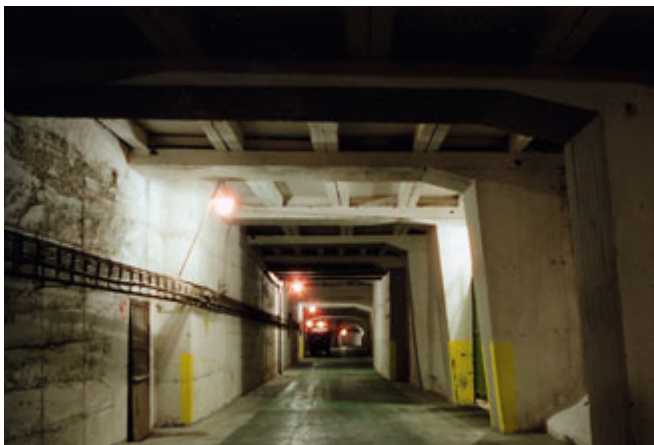
Dopravní chodba úložiště Richard
