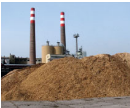
Skládka biomasy v Elektrárně Hodonín
