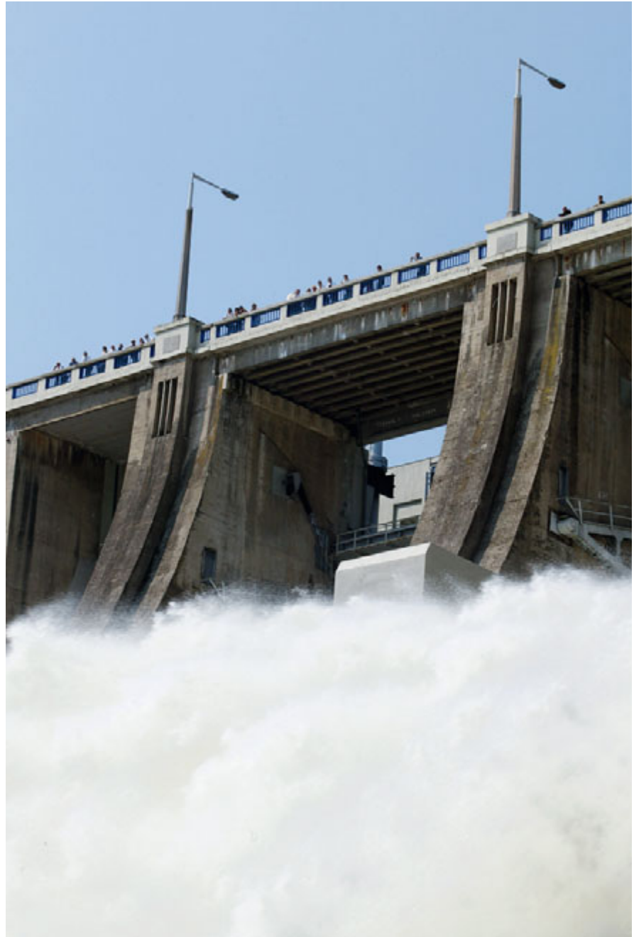
Vodní elektrárna Slapy
