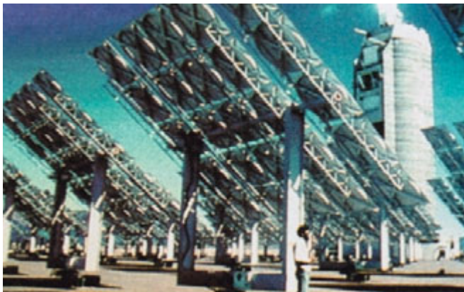
Sluneční tepelná elektrárna
