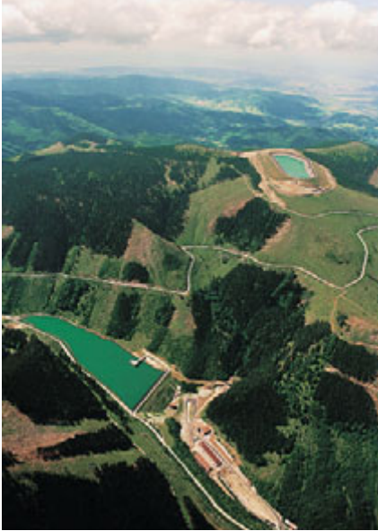
Přečerpávací vodní elektrárna Dlouhé Stráně. Na snímku vidíme horní i dolní nádrž.
