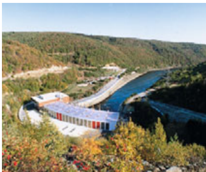
Vodní elektrárna Dalešice
