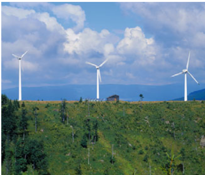
Větrná elektrárna Mravenečník
