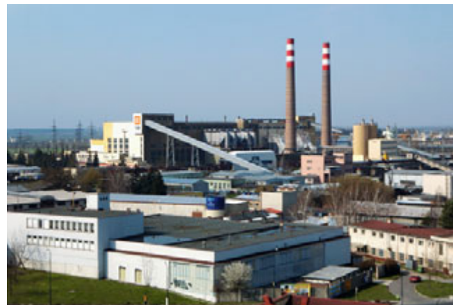
Po několika letech zkoušek spoluspalování biomasy s uhlím přechází fluidní kotel Elektrárny Hodonín na spalování čisté biomasy
