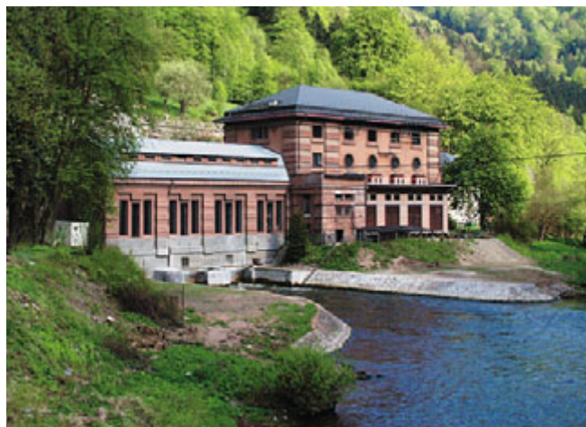
Vodní elektrárna Spálov
